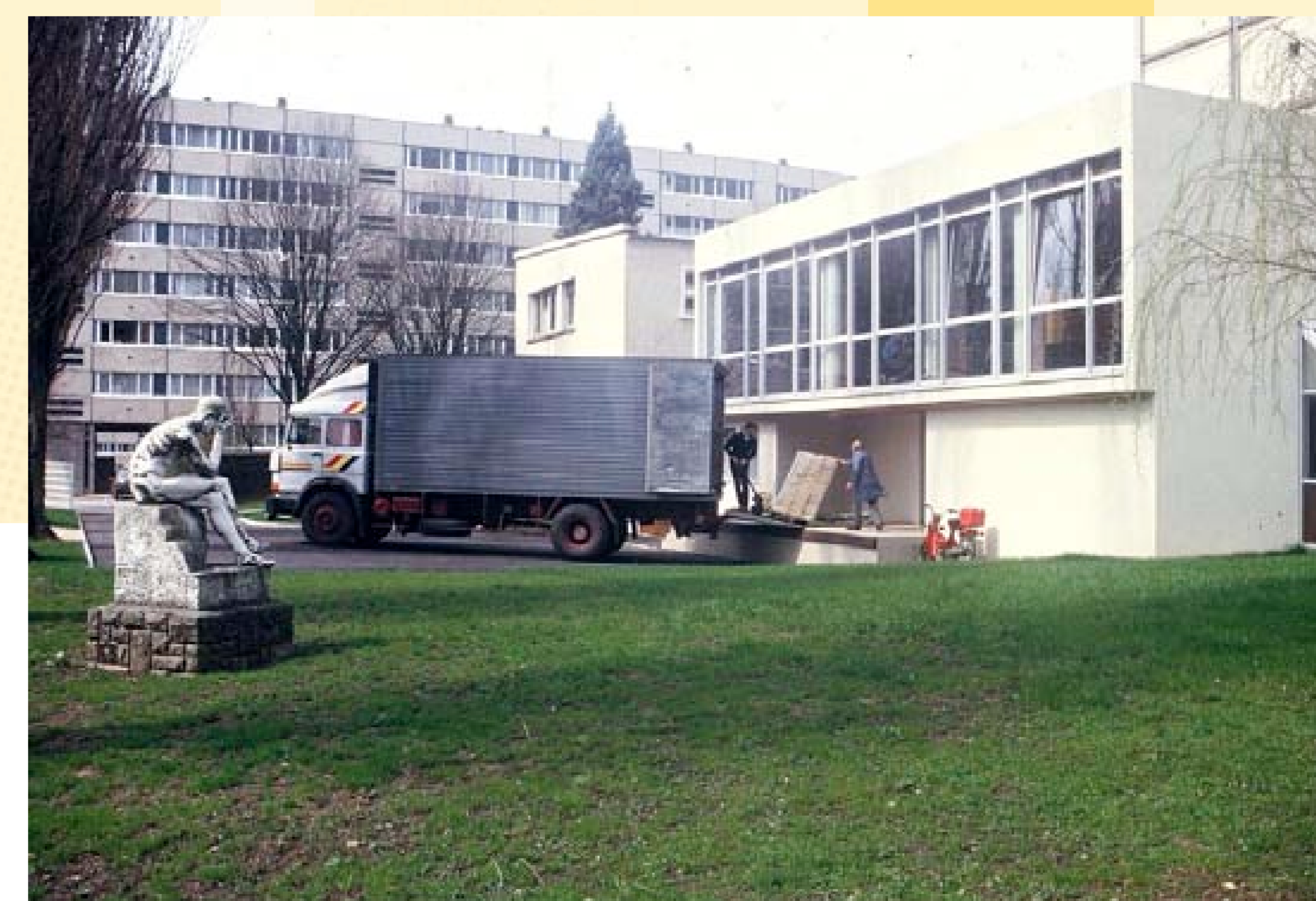
Un quai de déchargement permet l'entrée de nouveaux documents (4 Fi Archives 165)
