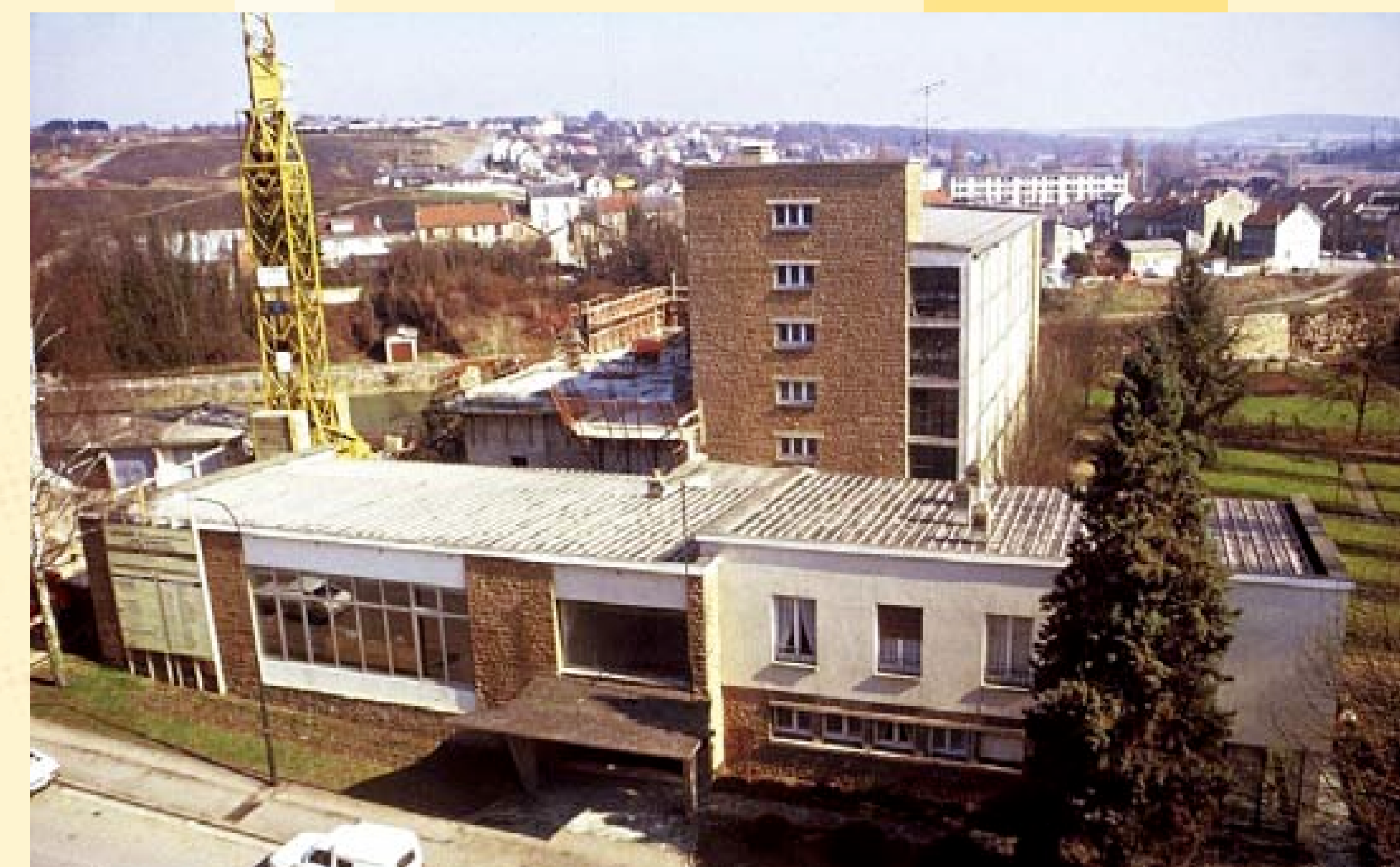
Vue générale du chantier (4 Fi Archives 114)
