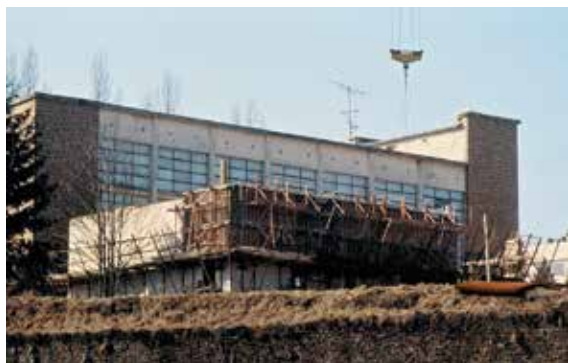
Construction de l'extension des AD08, 1986
