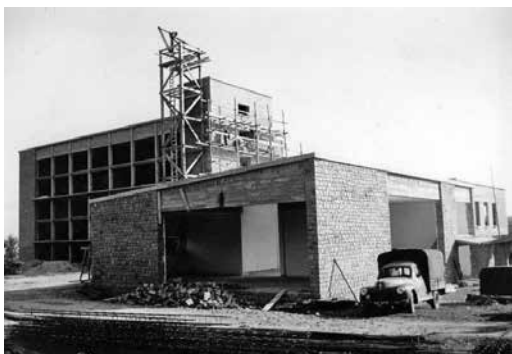
Construction du nouveau bâtiment des AD08 en 1957,
