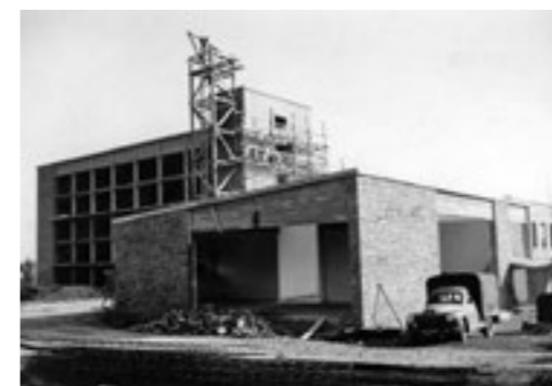
Construction du nouveau bâtiment des AD08 en 1957,
