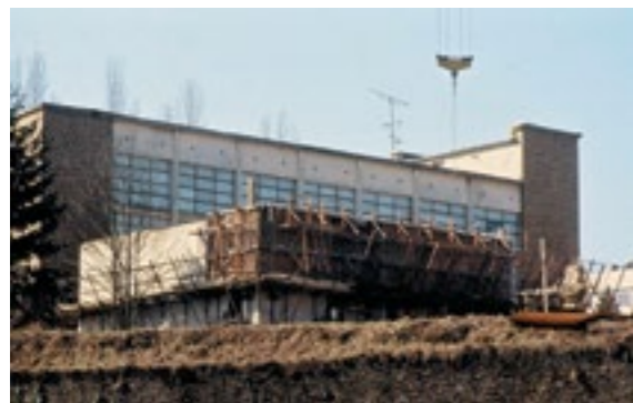
Construction de l'extension des AD08, 1986
